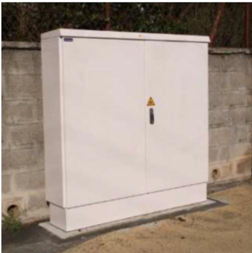
A partir de ces armoires, la fibre se distribue dans les rues du quartier, soit en sous-terrain (lorsque les réseaux existants le permettent), soit en aérien (accrochée à des poteaux). Elle alimente alors des PA (Points d'Aboutement) puis des **PBO (Points de Branchement Optique)** situés dans la rue ou dans les immeubles (suite à un accord avec les copropriétaires).
